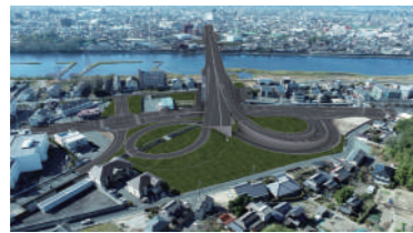
下中野平井線の旭川工区
